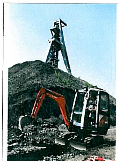
Am Schacht Hugo 2 wird ein Kabelschacht gebaut zur Stromversorgung. Bilder: Thomas Schmidtke / waz Foto: WAZ
